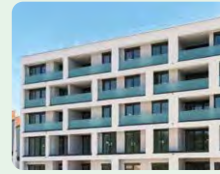
Mit der Fertigstellung der Fassade konnte auch das Gerüst am BGZ2 entfernt werden. Fotoquelle: Stadt Geretsried
