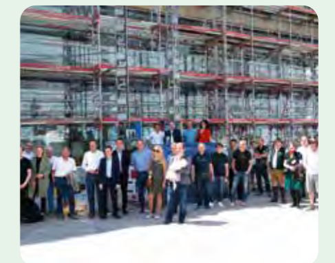
Waren begeistert vom Baufortschritt: die Besucher des Richtfestes für das neue Sparkassen-Gebäude. Fotoquelle: Sparkasse Bad Tölz-Wolfratshausen
