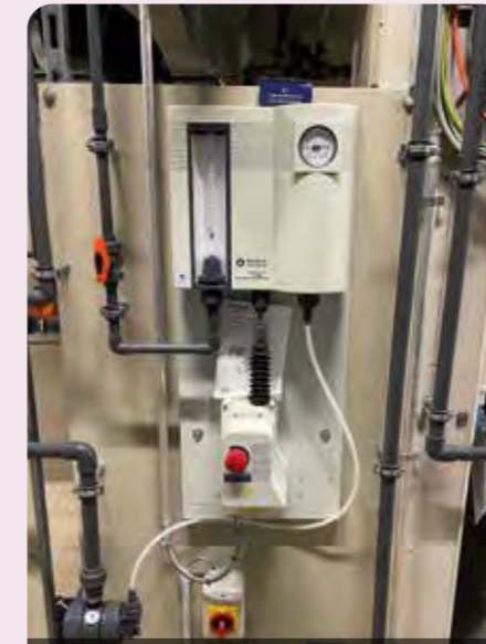
Für einen ordnungsgemäßen Betrieb des Hallenbades braucht es eine Menge Technik, die regelmäßig kontrolliert werden muss. Fotoquelle: Stadt Geretsried
