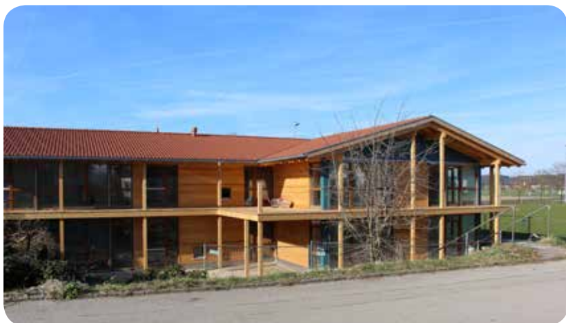
Der neue Temenos Kindergarten in Gelting von Süden....
