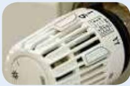
Bei mechanischen Thermostatventilen entspricht die mittlere Stufe (Stufe 3 bei einem 5-stufigen Ventil) 20°C Raumtemperatur. Eine Stufe bei einer fünfstufigen Skala entspricht in etwa 4°C. Somit erreicht man bei „Stufe 5“ eine Raumtemperatur von 28°C.
