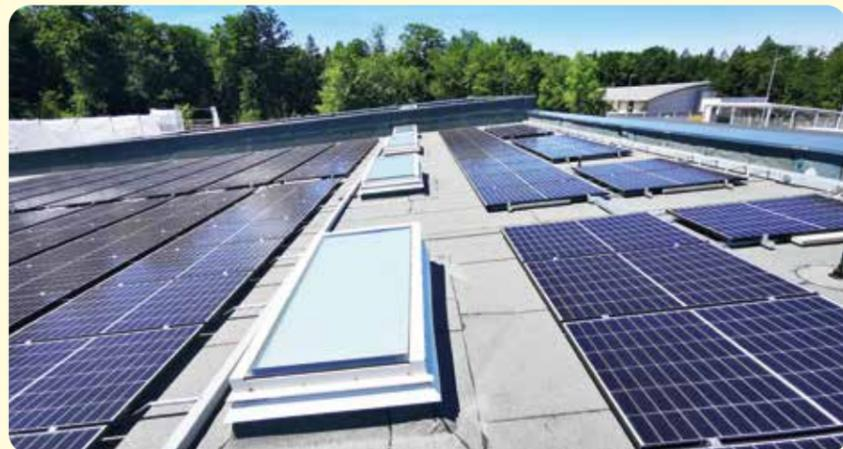
Auch das Hallenbad Geretsried besitzt eine große Photovoltaikanlage auf dem Dach, um den Strom für Lüftung und Beleuchtung selbst zu nutzen.
